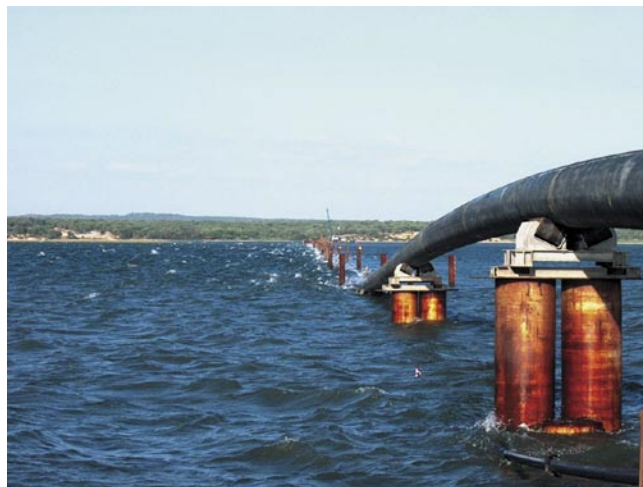
Fig. 4 Prowadzenie rurociągów pomiędzy dalbami.
