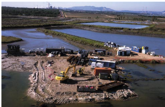
Fig. 6 Operacja wciągania rurociągu pomiędzy punktami 4 i 5.
