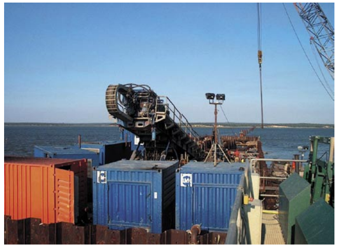
Fig. 7 Urządzenie wiertnicze klasy 350 ton na platformie w punkcie 3.
