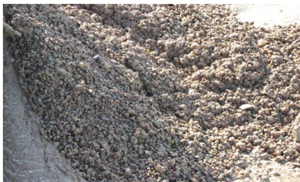
Fig.3. Hiszpania, Sewilla – separacja urobku na sitach; Długość otworu: 340 m; Rurociągi stalowe DN 750 + DN 100; Długość sekcji żwirowej: 120 m; Siła ciągnięcia: 35 T.
