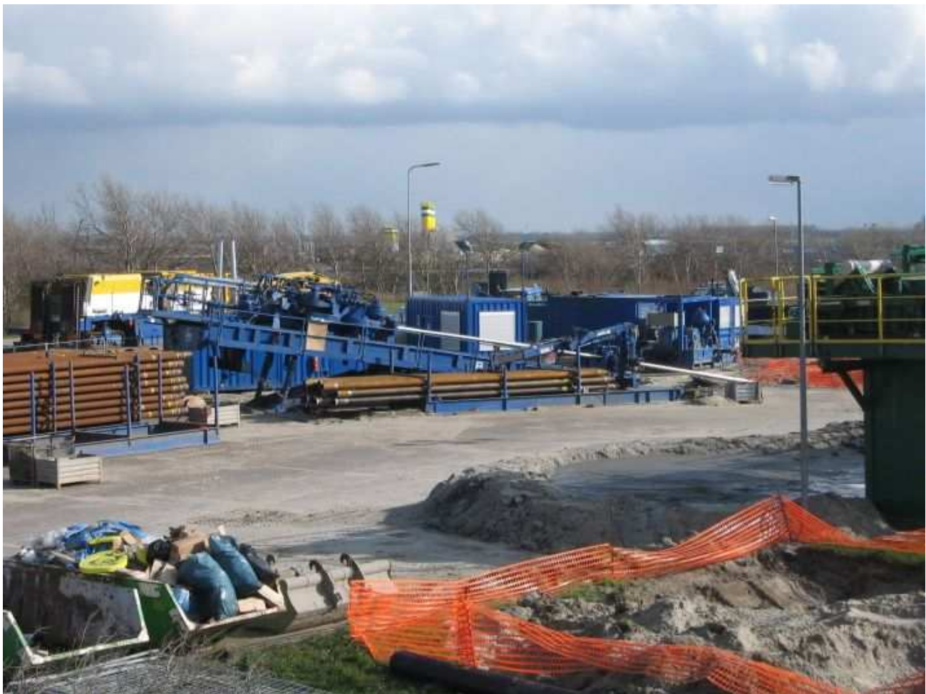
LMRs 250 t Rig • Max. Zugkraft 320 t • Max. Drehmoment 120 kNm
