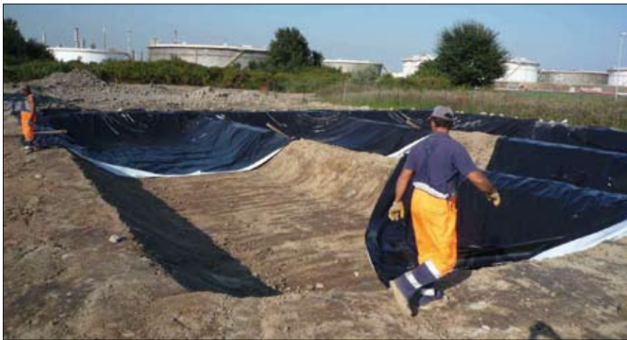
Foto 6 – Predisposizione delle vasche di accumulo fanghi lato uscita, rivestite con telo impermeabile
