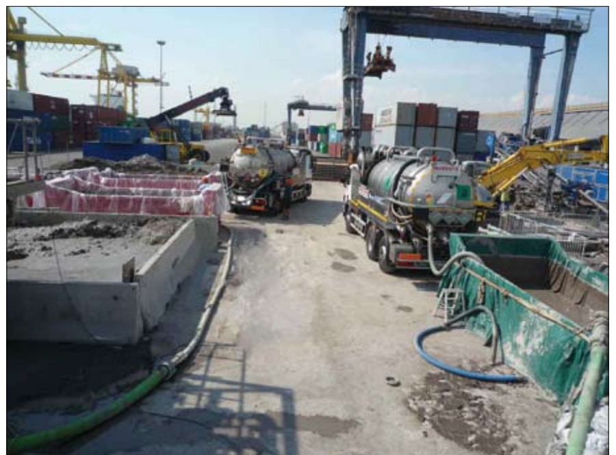
Foto 5 – Cantiere di ingresso durante il tiro della condotta. Si vedono gli scarrabili per l'accumulo temporaneo dei fanghi e le botti spurgo per il loro allontanamento. Sulla destra il bacino di contenimento dei cuttings
