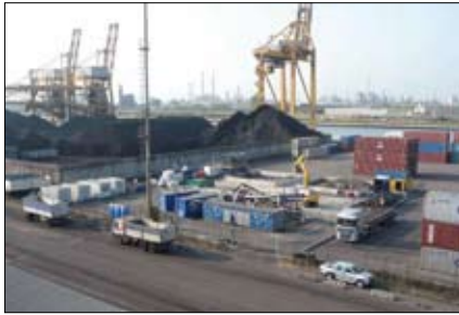
Foto 1 – Vista generale dell'area cantiere lato ingresso
