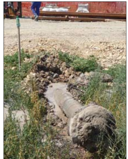
Foto 9 – Uscita del foro pilota a 50 cm dal target
