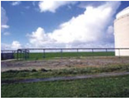
Baustelleneinrichtungsfläche auf dem DOW-Gelände
