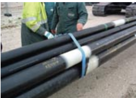
Bündelung der Einzelrohre
