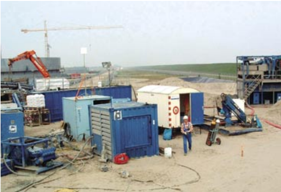
Baustelleneinrichtung am Austritt
