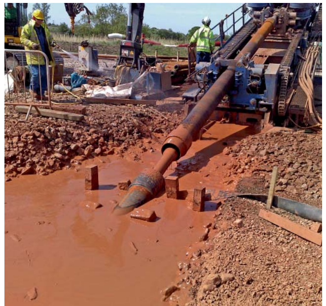
Fot. 6. | Zabudowa casingu
